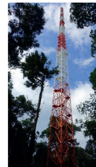
A torre ATTO de 325 metros de altura na Amazônia Central será usada para gases traços, aerossóis e outros, medindo continuamente ao longo dos 5 anos deste projeto
