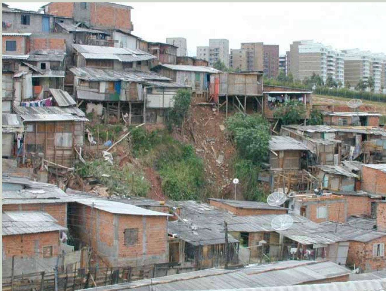
Figura 57: Área de risco de acidentes de escorregamentos induzidos por cortes e aterros em assentamento precário. . Fonte: IPT, 2010
