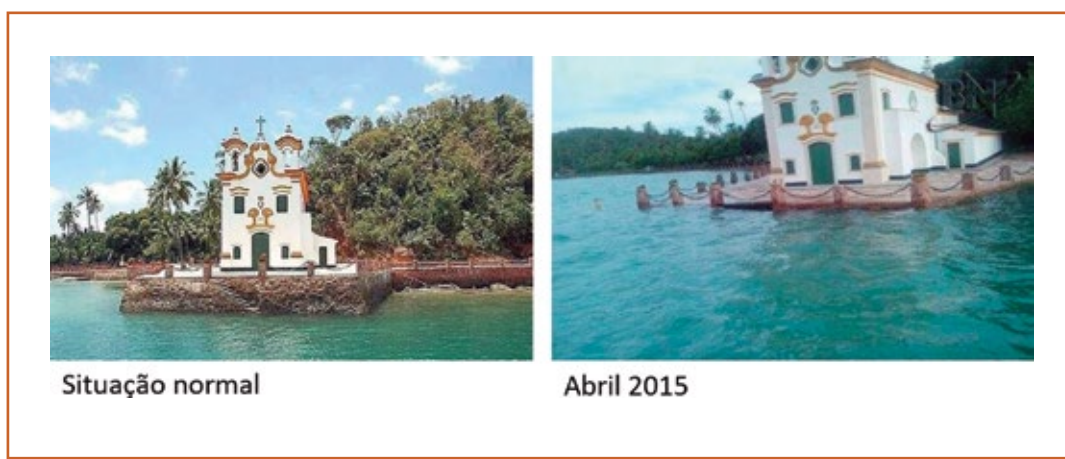
Figura 7.14 Igreja de Nossa Senhora do Loreto, na Ilha dos Frades, em Salvador. Em abril de 2015, a maré alcançou 3,30 metros de altura e quase atingiu a construção de 1617. Na época, o que salvou a construção histórica foi a construção de uma barreira pela proprietária da Fazenda Loreto.
