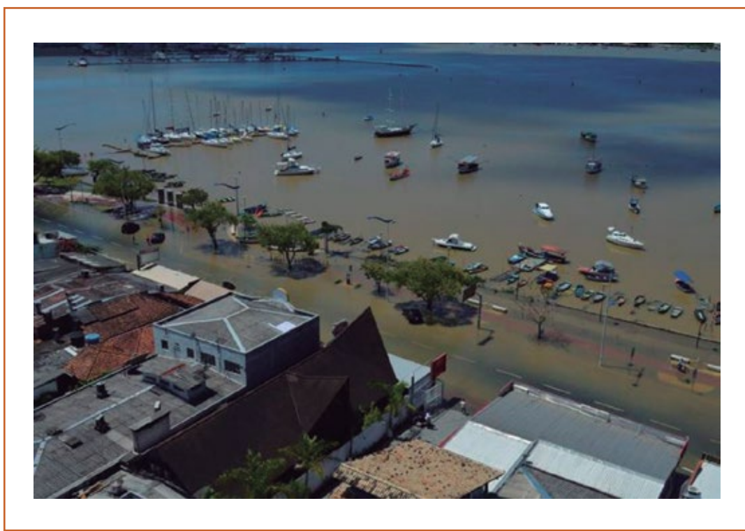
Figura 7.41 Inundação na Avenida Beira Rio em Itajaí. Foto: Luiz Carlos Souza / RBS TV.
